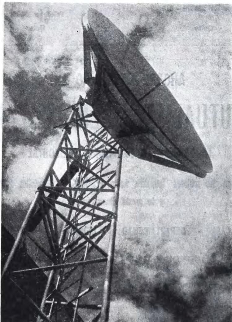
Antena, parabólica de 3,50 metros de diámetro, instalada en San Juan, para el sistema de Radio - Enlace entre Quito - Ibarra - Tulcán - Colombia.
